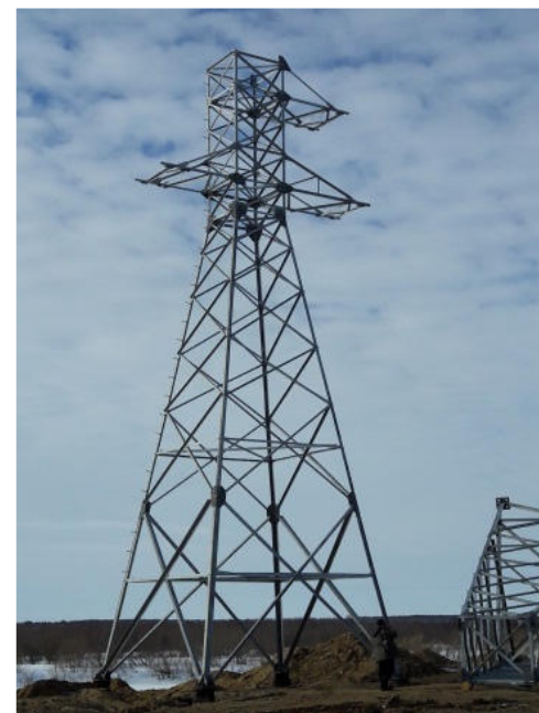
Реконструкция объекта «Межпоселковая ЛЭП 10 кВ: с. Нижняя Пеша - д. Волоковая, Ненецкий автономный округ»
