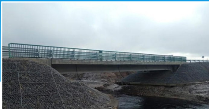
Мост через ручей «Лахтенный» в с. Несь НАО после капитального ремонта
